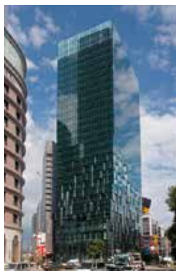
大阪富国生命ビル
